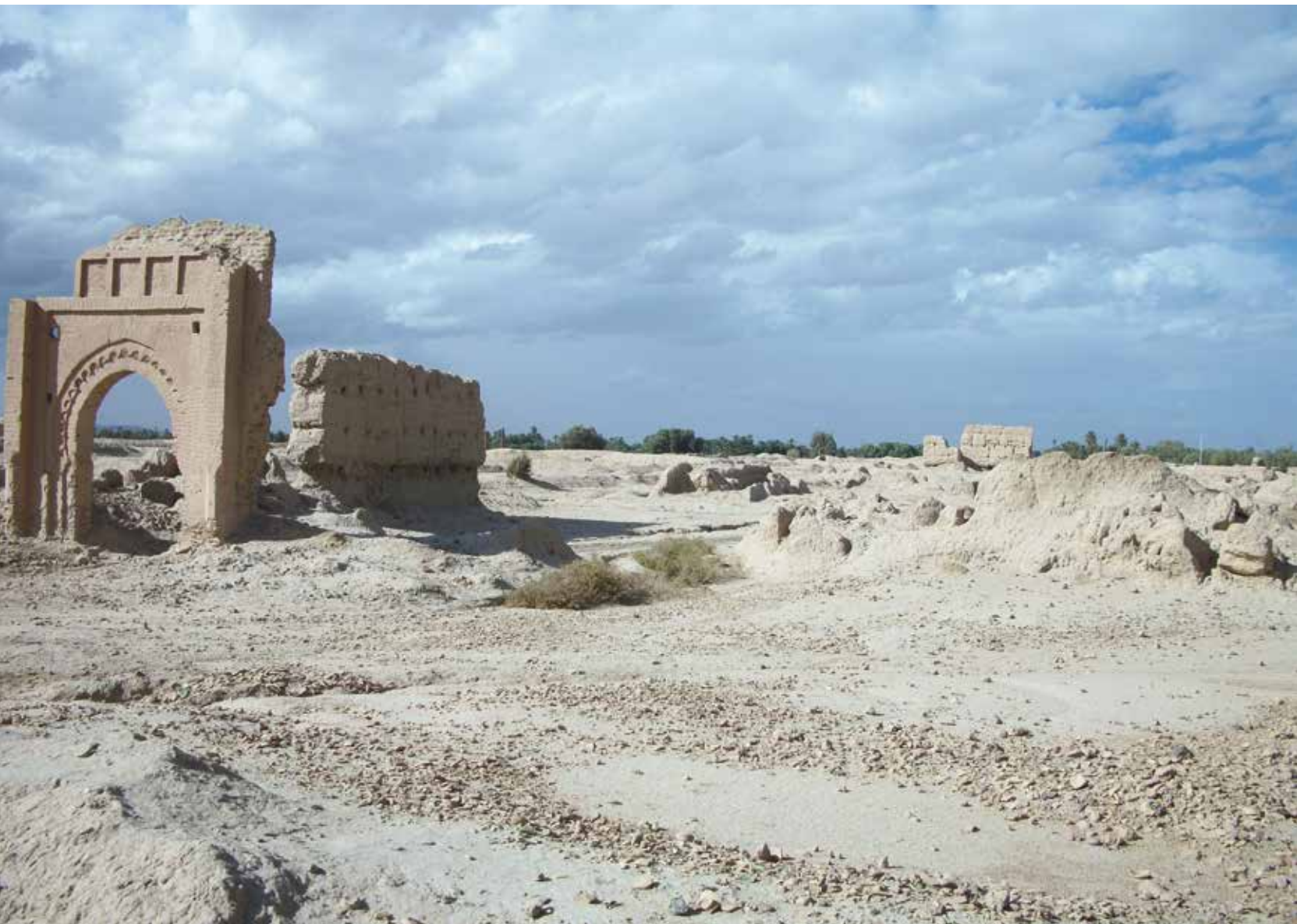
Ruines du ksar de Bahir, à l'ouest du site de Sijilmâsa.
